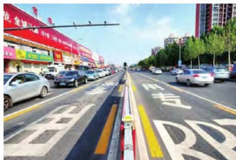
専用道路付きな ので、実は通信 遠隔制御は、それ ほどではない
